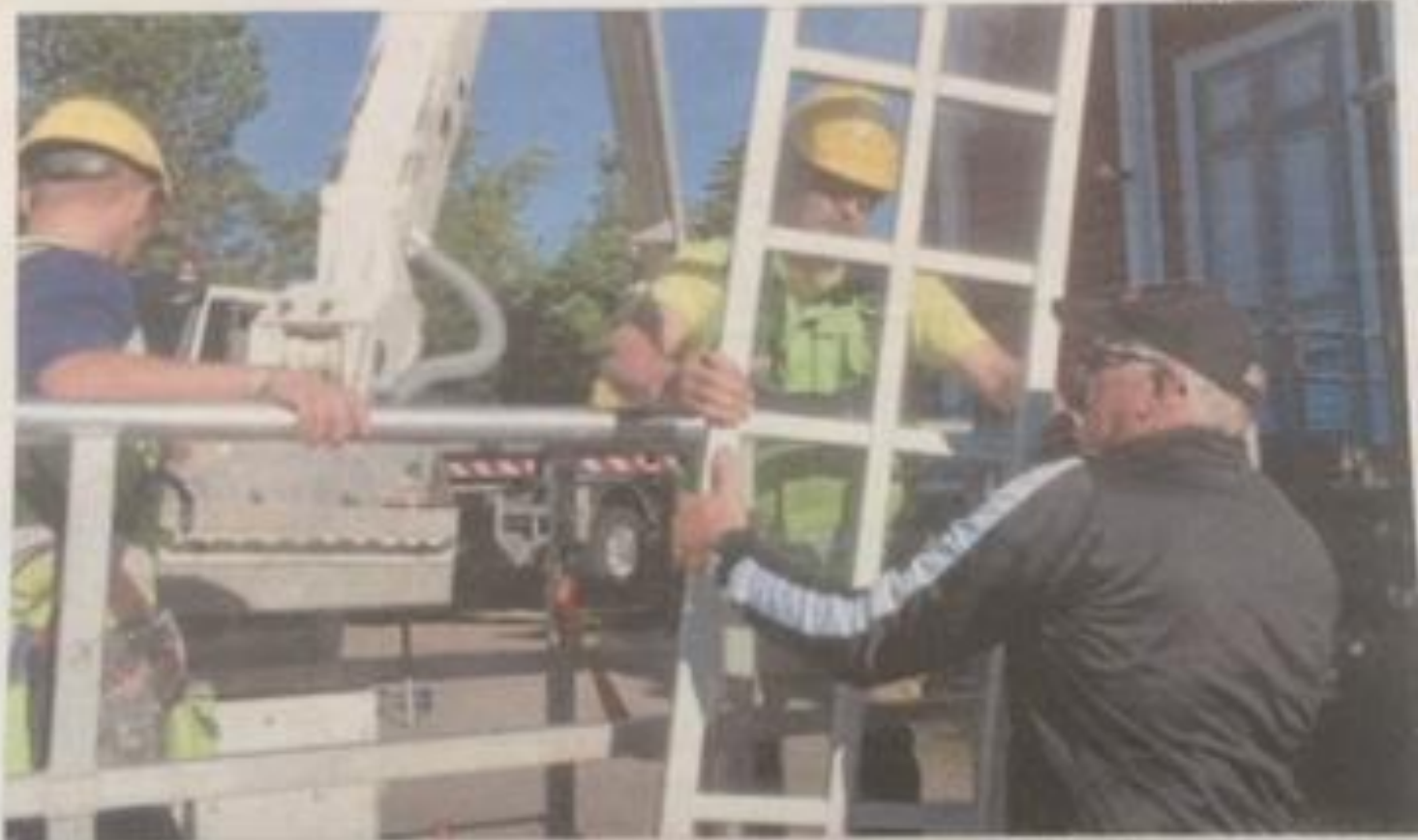
Korjauksen tarpeessa olevat ikkunapokat haettiin korjattavaksi nosturilla lähes 40 metrin korkeudesta. Kai Ahonen kuuvutti lyhdyn ikkunaristikon Paavo Kainulie.
